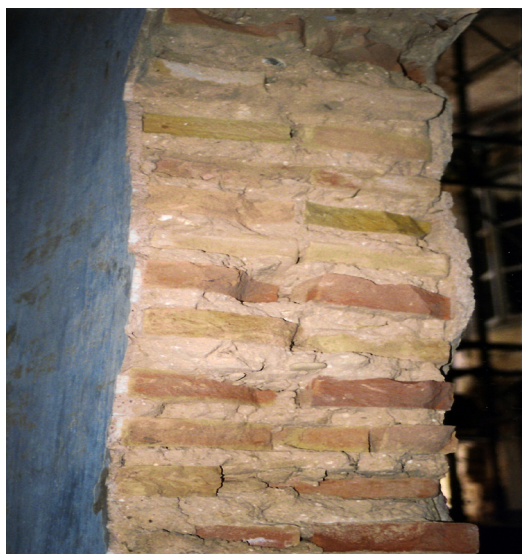
Fig. 5. Ejemplo de muro de obra de ladrillo.
