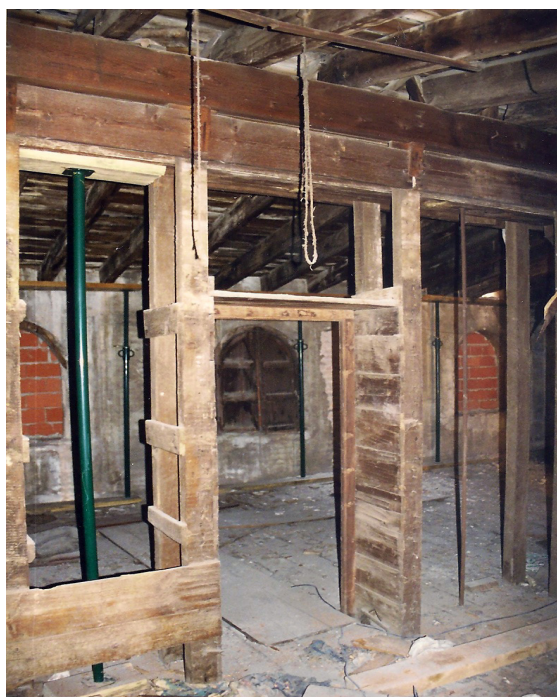
Fig. 7. Detalle del tabique de madera y puerta entre crujías del taller de la C/ Barraca.
