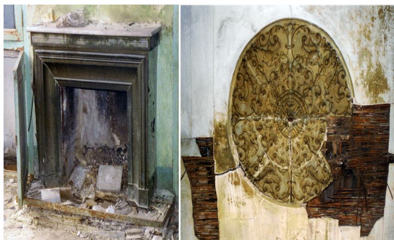
Fig. 10. A la izquierda, chimenea del salón. A la derecha, florón del techo de pasillo central de la planta baja.
