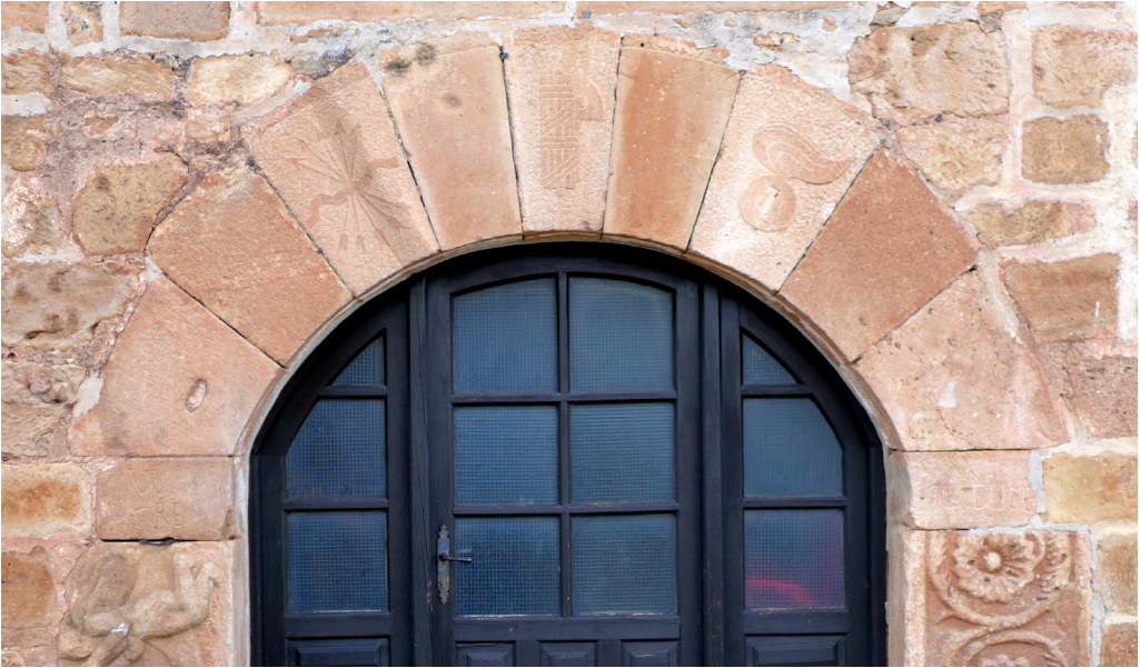
Figura 5. Yugo y flechas, fascio y bomba en las dovelas de un arco soportado por grandes piezas romanas decoradas que hacen de jambas.
