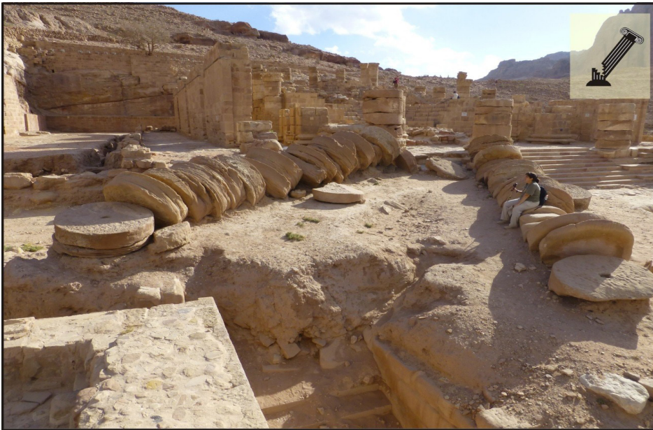
Figura 7. Caída orientada de columnas en el Gran Templo romano de la ciudad nabatea de Petra (Jordania). Efecto cosísmico primario en la fábrica del edificio, son estructuras de deformación generadas por deformación transitoria del sustrato.
