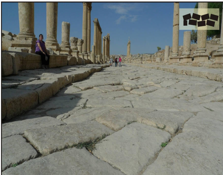
Figura 9. Bordillo y enlosado plegados del decumanus máximo de la ciudad romana de Jerasa (Jordania). Efecto cosísmico primario en la fábrica del edificio, son estructuras de deformación generadas por deformación transitoria del sustrato.
