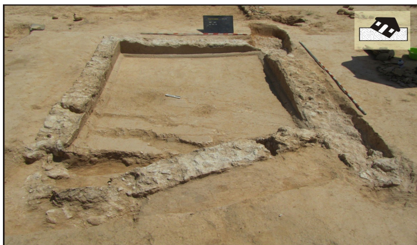
Figura 5. Licuefacción afectando a cisterna hidráulica en el yacimiento romano de La Magdalena (Complutum, Alcalá de Henares, España). Efecto cosísmico geológico primario.
