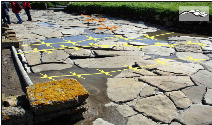
Figura 6. Pliegues (anticlinales y sinclinales) en el enlosado irregular del Decumanus Maximus de Baelo Claudia (Cádiz), deformado por el terremoto que destruyó la ciudad en 350-395 AD. Los pliegues representados en amarillo son perpendiculares a la pendiente topográfica y asociados a dicho terremoto. Los de color naranja son paralelos a la pendiente y están asociados a fenómenos de ladera. Efecto cosísmico geológico primario.
