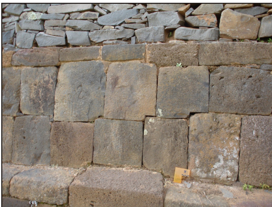
Figura 4. Engatillados antisísmicos en las Yácatas de Tzintzuntzan (Cultura Purhépecha o Tarasca), lago de Pácuaro (Michoacán, México). Estos impiden el desplazamiento horizontal entre bloques de sillería provocado por terremotos.
