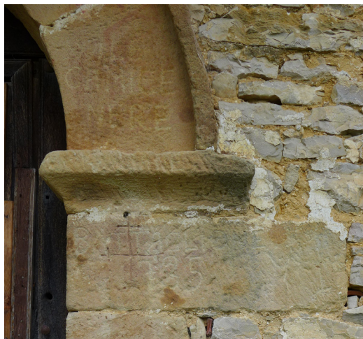
Figura 1. Grafitos incisos en la dovela de arranque del arco y el sillar superior de la jamba oriental de la portada de la ermita de Santa Marina.
