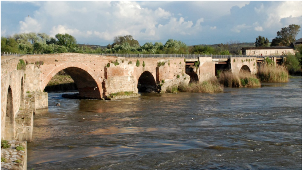
Figura 1. Vista actual del Puente Viejo de Talavera (Fundación Tagus).
