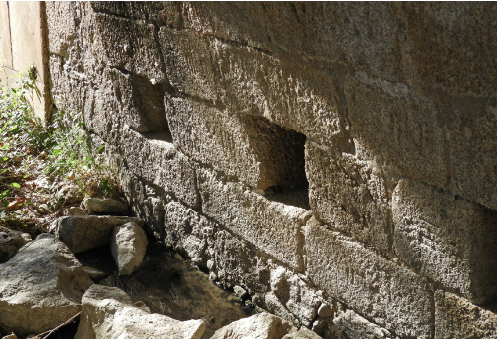
Figura 3. Vista inferior del intradós del primer arco con signos lapidarios (Fundación Tagus).
