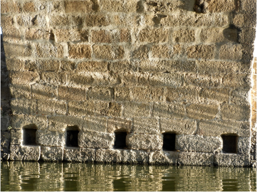
Figura 4. Vista del intradós del segundo arco con signos lapidarios (Fundación Tagus).
