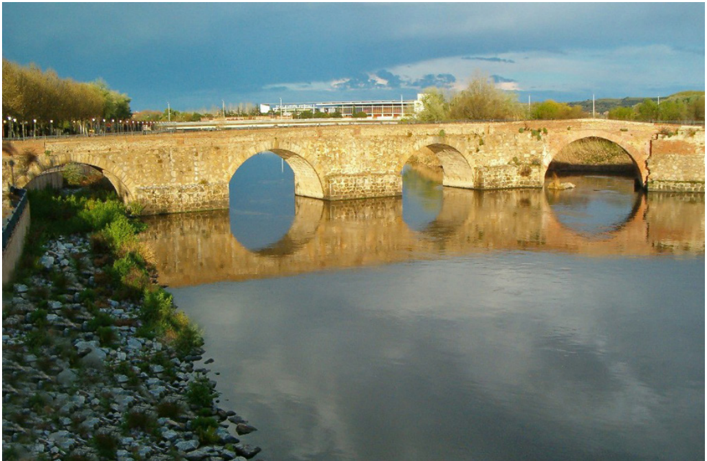
Figura 2. Tramo del puente asociado a la obra del cardenal Mendoza (Fundación Tagus).
